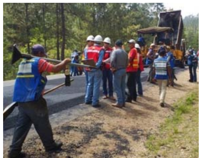
Visita al Proyecto Rehabilitación Carretera Olancho, Sección III, Río Dulce-Limonos, realizada el 9 de julio de 2013
