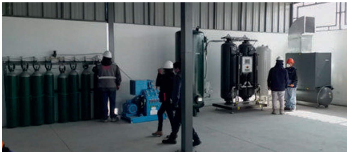
Fotografia 3: Primeira planta de oxigênio na região de Tacna, capacidade 480 m 3 por dia.
